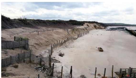
Même secteur en novembre 2017, à gauche : une partie du sable est partie mais le gros du volume déposé est encore en place. À droite, en septembre 2018, le recul s'est poursuivi (photos Y. Battiau-Queney). Le piégeage de sable par les fascines n'a pas été efficace, car la mobilisation du sable par le vent est difficile sur une plage qui reste humide trop longtemps.
