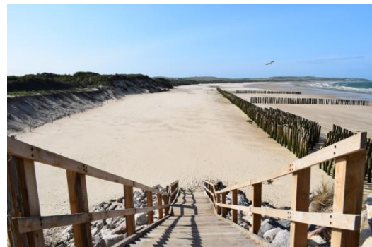
Même secteur en novembre 2017, à gauche : une partie du sable est partie mais le gros du volume déposé est encore en place. À droite, en septembre 2018, le recul s'est poursuivi (photos Y. Battiau-Queney). Le piégeage de sable par les fascines n'a pas été efficace, car la mobilisation du sable par le vent est difficile sur une plage qui reste humide trop longtemps.
