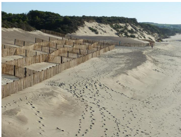
Opération de réensablement de la dune d'Aval avec installation de casiers de fascines destinés à piéger le sable. Photos Y. Battiau-Queney du 9 septembre 2016
