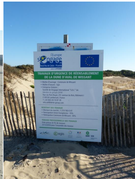
Opération de réensablement de la dune d'Aval avec installation de casiers de fascines destinés à piéger le sable. Photos Y. Battiau-Queney du 9 septembre 2016
